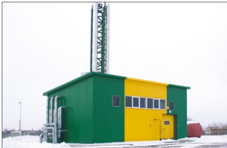
Внешний вид котельной
